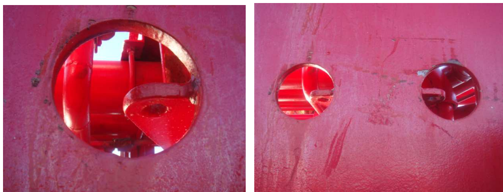
Figura 6 - Exemplo de olhais embutidos na chaparia da estrutura do "horse bar"
