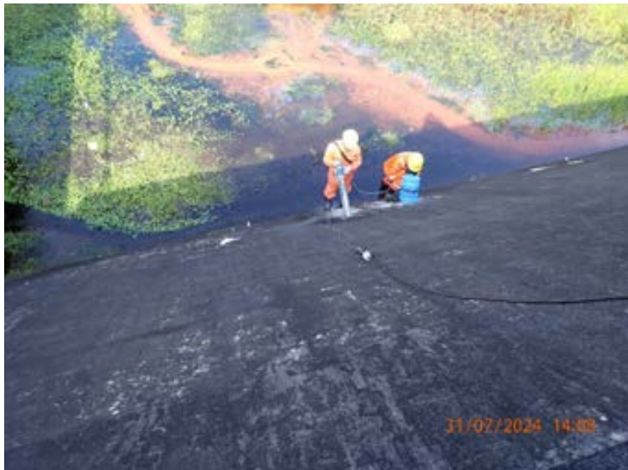
Figura 67: Manutenção em andamento na data da visita.
