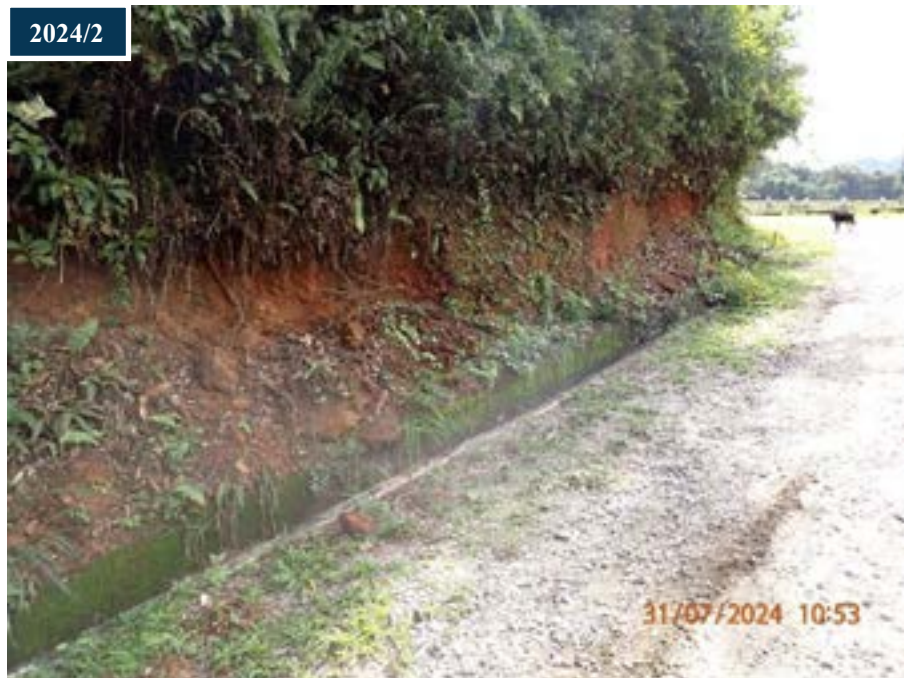
Figura 1: Continuidade do processo erosivo na via de acesso à crista.
