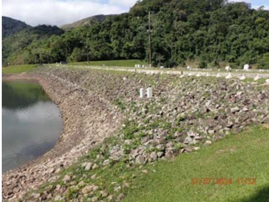
Figura 6: Vista geral do talude de montante.
