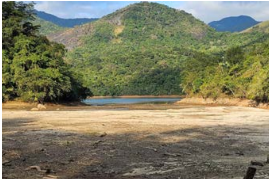
Figura 54: Assoreamento elevado das margens do reservatório a montante do vertedouro.
