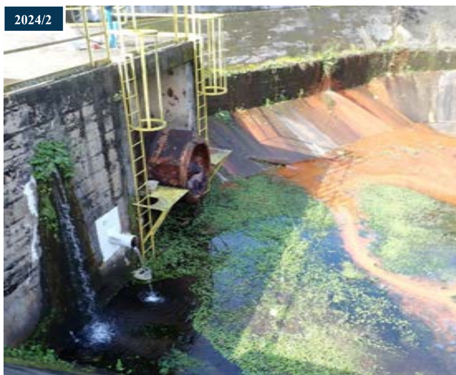
Figura 65: Situação da bacia de dissipação na inspeção anterior e atual.
