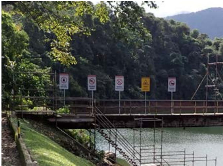
Figura 4: Placas de advertência instaladas.
