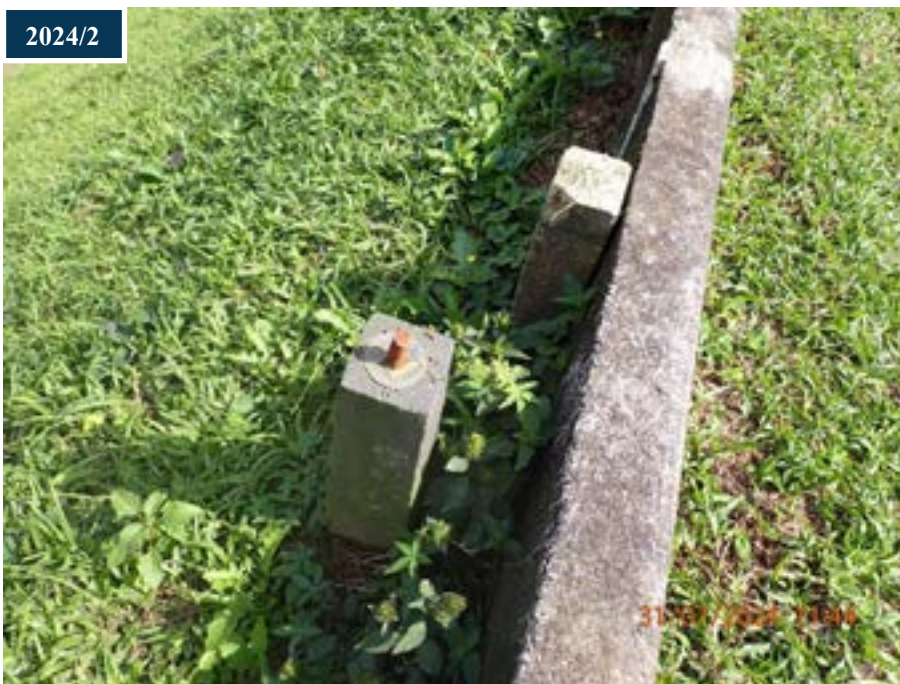
Figura 27: Marcos de referência sem a devida identificação.
