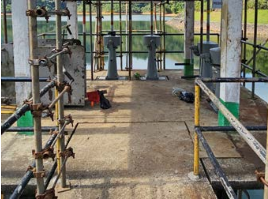
Figura 62: Necessidade de abertura de alçapão para inspeção interno da torre.
