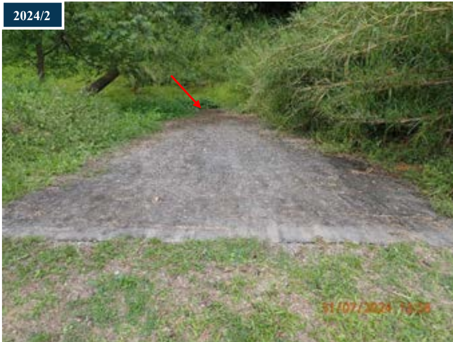
Figura 21: Constância na observação de sinais de surgência a jusante da bacia de descarga.
