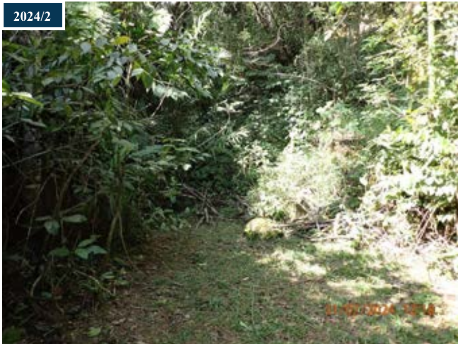
Figura 25: Permanência da situação de deslizamento que afeta o piezômetro SRP-115.
