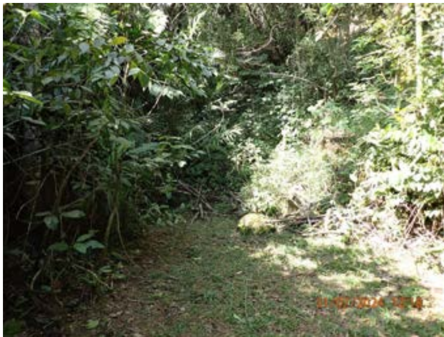
Figura 33: Escorregamento de talude sobre o PZ 115 na ombreira esquerda.
