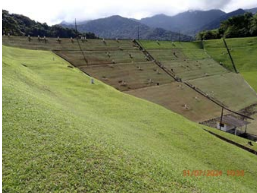
Figura 12: Vista geral do talude de jusante.
