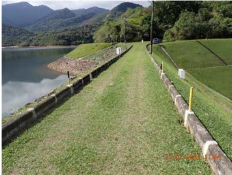
Figura 8: Vista geral da crista da Barragem Saracuruna
