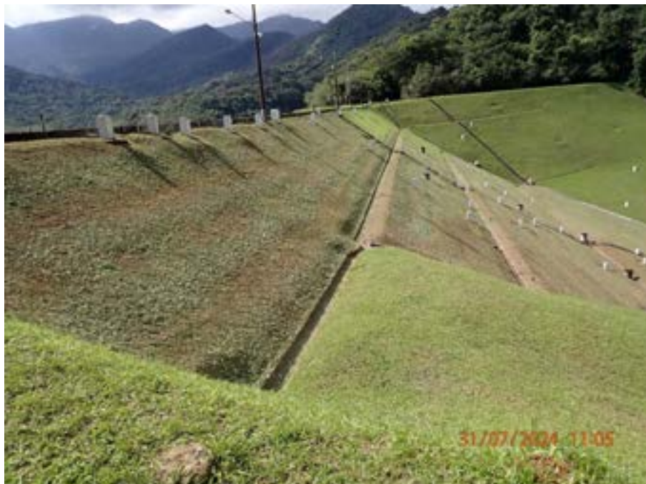
Figura 13: Talude de jusante com revestimento vegetal roçado.
