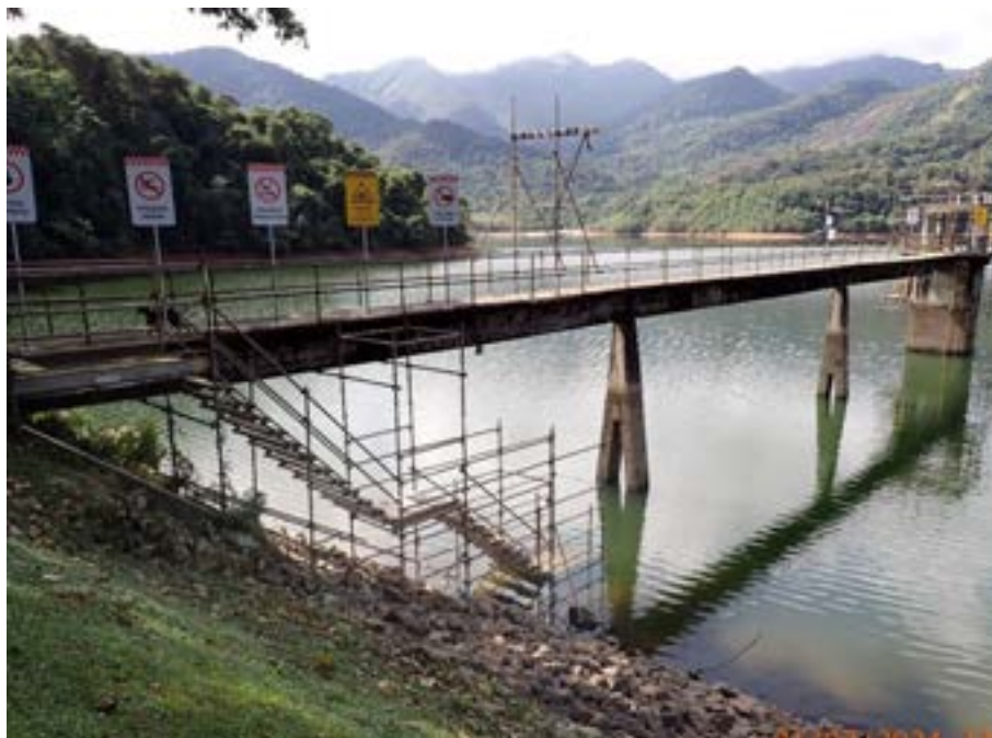
Figura 57: Vista geral da passarela de acesso de torre.
