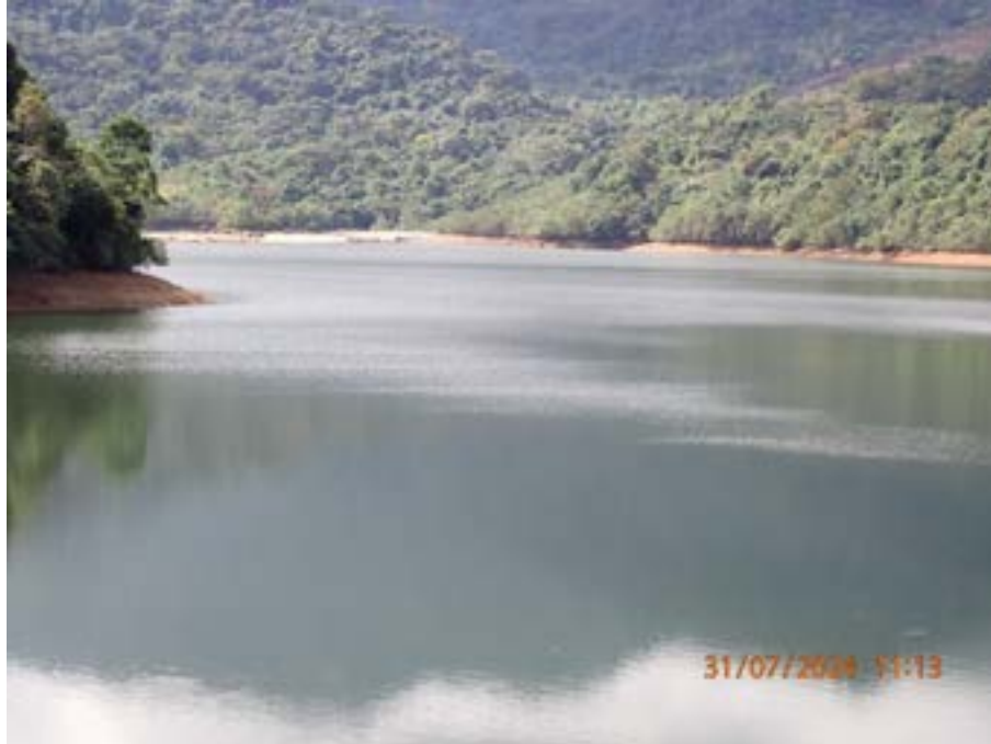
Figura 53: Vista geral do reservatório.
